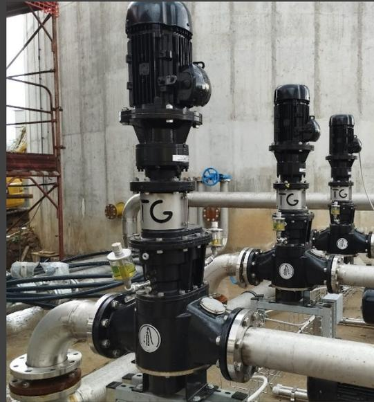
Zerkleinerer stromaufwärts von Exzentrerschneckenpumpen zur Vermeidung von Schäden und Verstopfungen durch Feststoffe.
